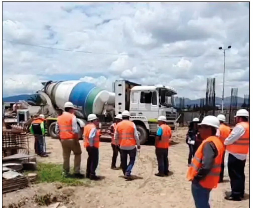
Trabajos en el aeropuerto Oriel Lea Plaza
