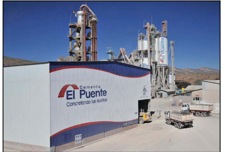
Fábrica de cemento El Puente
